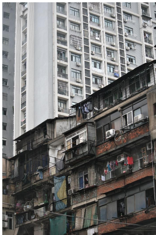
Figur 69 Gammelt og nyt boligbyggeri i Wuhan. Boligblokken i forgrunden er formentlig fra 1970 eller 80'erne, og det regnes for meget gammelt i Kinas storbyer, hvor vedligeholdelse af boligejendomme er ukendt. Det 'gamle' rives ned og nyt opføres alle vegne. Beboerne i den gamle boligmasse bliver tilbudt genhusning eller økonomisk kompensation. Foto:Otto Leholt, 2012
