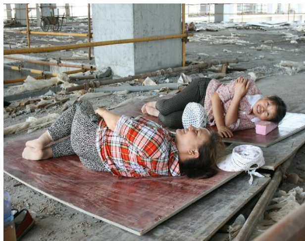
Figur 74 To kvindelige migrantarbejdere, som arbejder som bygningsarbejdere på Huawei's nye R&D center i Xi'an, får en middagslur. Forfatteren var blevet tilbudt en dags arbejde på byggepladsen, men takkede venligst nej tak, ikke mindst pga. de 40 ° varme og de noget usikre arbejdsforhold, med åbne huller i betongulvene, bambusstilladser og almindeligt byggerod. Foto: Otto Leholt, 2014
